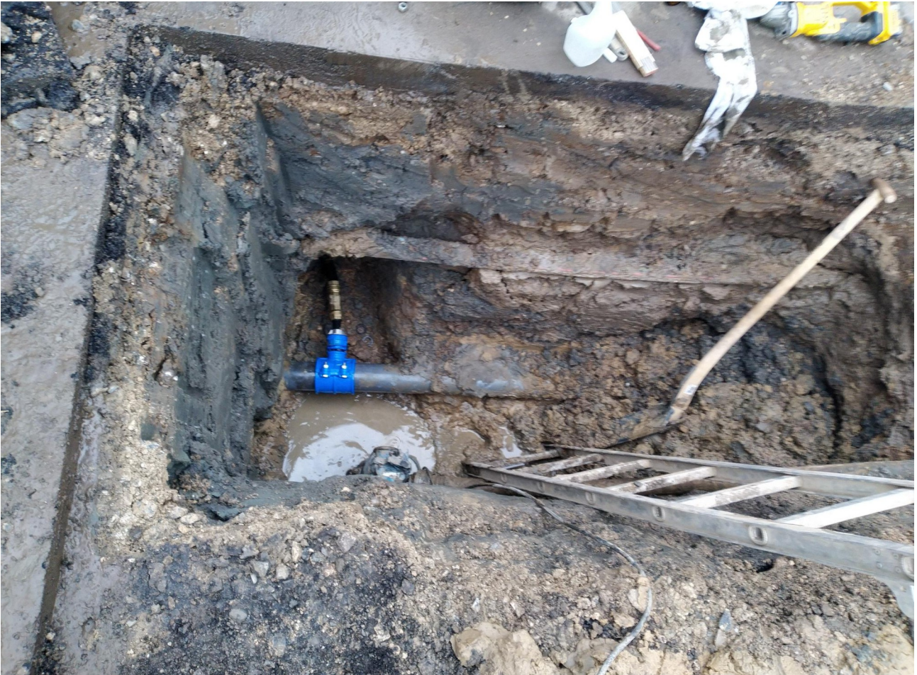
Figur 6. Billedet viser den reparerede anbring
